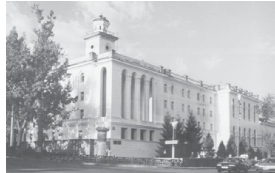
Абай және Достық даңғылдарының қиылысындағы бұрынғы Жоғары партия мектебі ғимараты. Сәулетші Ким До Сен
