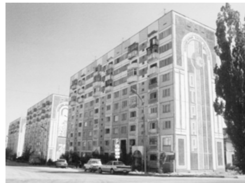
“Отырар” ЖТК-ндегі 158-сериялы ірі панельді тұрғын үйлер (Науаи көшесі) Крупнопанельные жилые дома 158-й серии в МЖК “Отырар” в районе ул Навои
