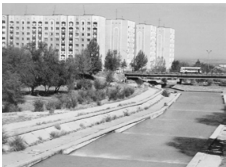
Әйтеке би даңғылының солтүстігіне қарай салынған 9 қабатты, ірі панельді, 158-сериялы тұрғын үйлер (Үлкен Алматы өзенінің батысына қарай) Застройка 9-этажными крупнопанельными жилыми домами 158-й серии северной стороны пр.Аль-Фараби, западнее р. Большой Алматинки
