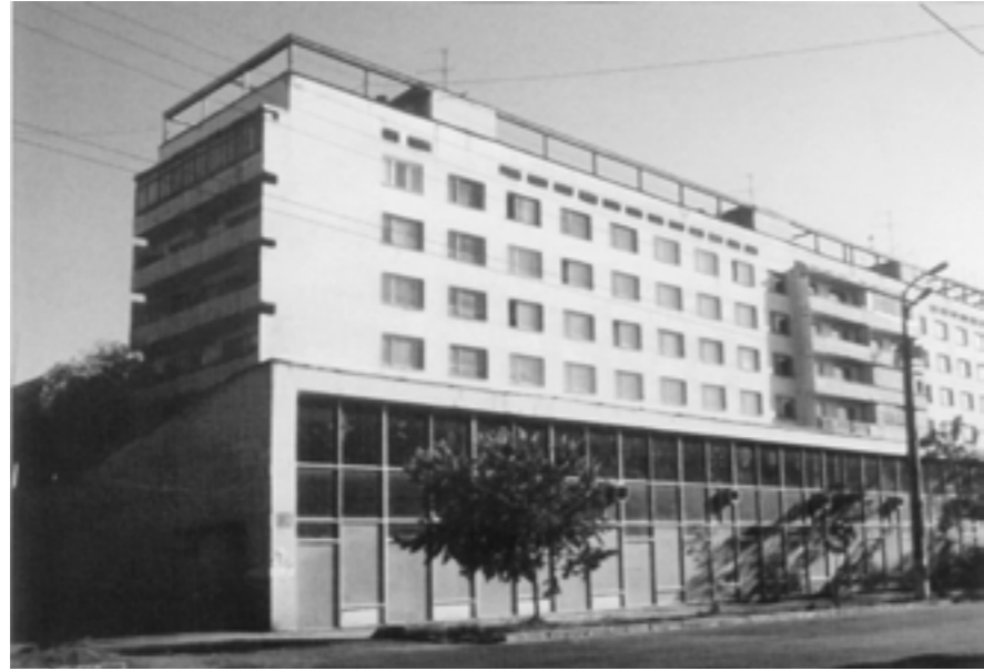
Гоголь көшесі мен Абылай хан даңғылы қиылысындағы “Юбилейный” дүкені орналасқан тұрғын үй. Сәулетшілер В.А.Пешков, Б.В.Дмитриевский
