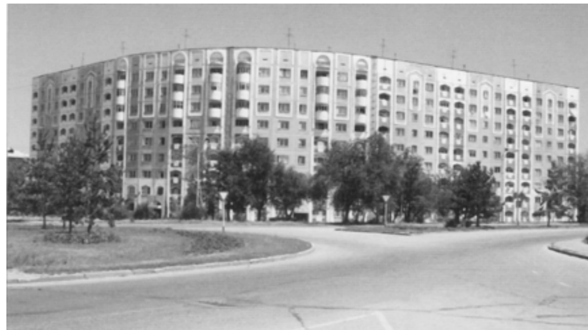
158-сериялы ірі панельді тұрғын үй (Әл-Фараби даңғылы мен Науаи көшесінің қиылысы) Жилой крупнопанельный дом 158-й серии на пересечении пр.Аль-Фараби и ул.Навои
